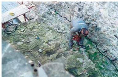
Perforazione dell'estradosso dell'arco
