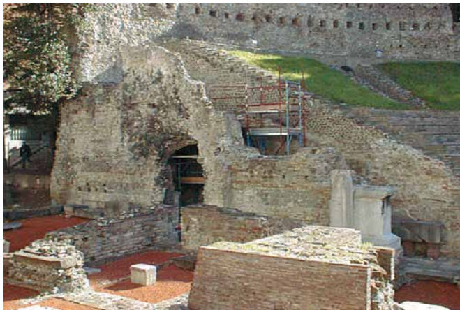
Particolare dell'arco consolidato
