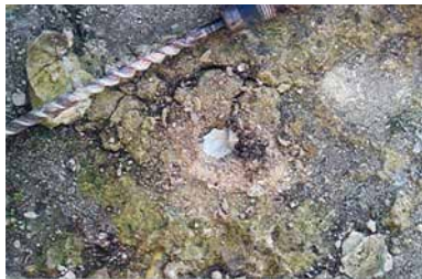
Foro di iniezione orizzontale con rabbocco di boiaccia sandtex fixinto lime
