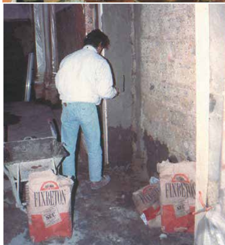
Fase applicativa dell'intonaco macro poroso sandtex fixbeton sec .
