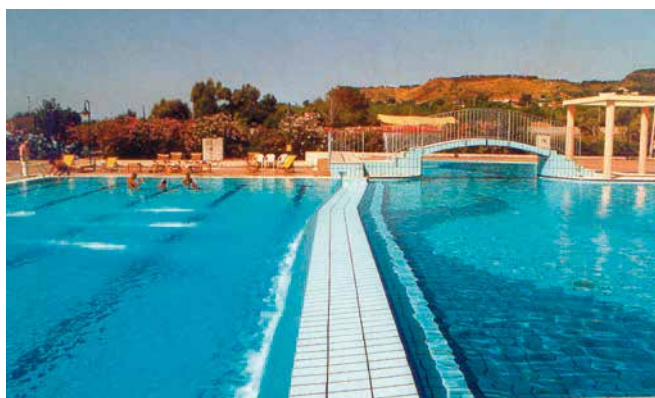
Le vasche strutturalmente indipendenti animate da tutta una serie di cascate sono state totalmente impermeabilizzate con i cementi impermeabilizzanti VANDEX
