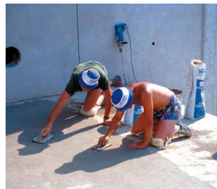
Dettaglio applicativo a platea del VANDEX BB 75
