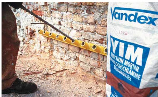
Realizzazione alla base della muratura di una serie lineare ed equidistante di fori nei quali è stata iniettata per caduta la boiacca a base di leganti idraulici **VANDEX INJECTION MORTAR (VIM)**
