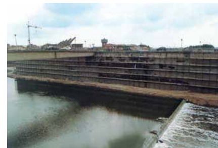
Veduta d'insieme della parete in cemento armato realizzata su una sponda del fiume Arno interessata dall'esteso intervento di ripristino e impermeabilizzazione ( sandtex fixbeton 45 e VANDEX BB 75 )
