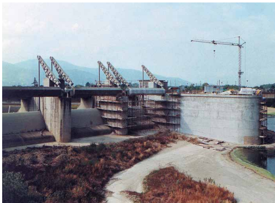
Veduta parziale della chiusa del canale scolmatore di Pontedera oggetto degli interventi di ripristino e impermeabilizzazione
