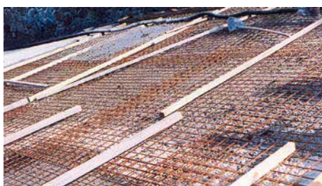
Posizionamento della rete elettrosaldata e stesura della malta strutturale sandtex fixbeton tx
