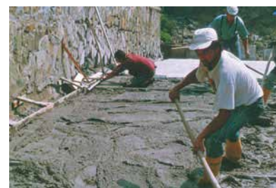
Posizionamento della rete elettrosaldata e stesura della malta strutturale sandtex fixbeton tx
