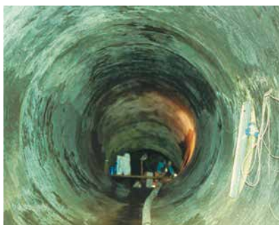
Veduta parziale di un tratto della condotta forzata interessata dagli interventi di ripristino strutturale ( sandtex fixbeton tx ) e impermeabilizzazione ( VANDEX SUPER )
