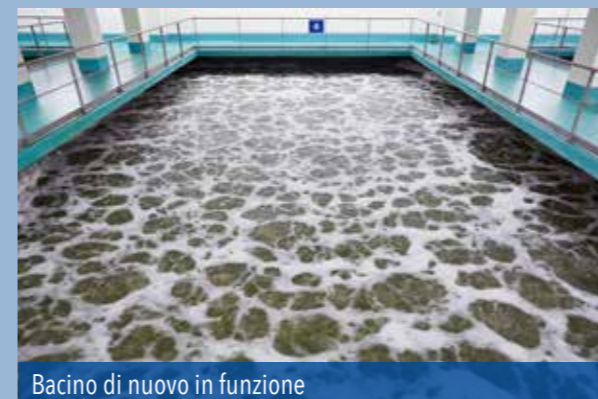
Bacini di trattamento biologico riabilitati
