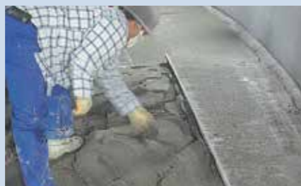
Posa del massetto
